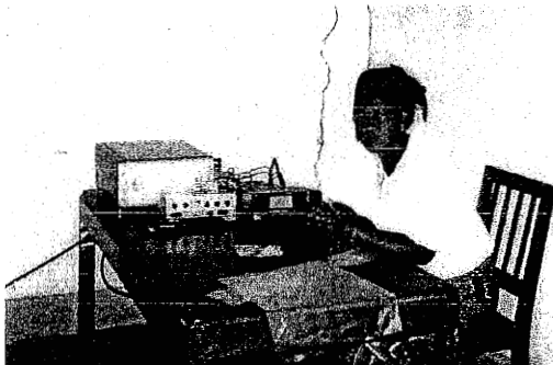
Installation de la nouvelle phonie ICOM au bureau de liaison de l'ICCN à Lubumbashi
